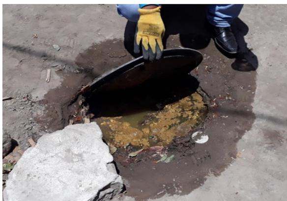
**Figura 1.** Estado situacional del biodigestor instalado para tratamiento de agua residual rural en el Centro Poblado Santeño –Tumán.
