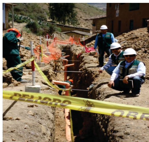
Figura 5: Instalación de tuberías, luego de haber realizado la excavación con las dimensiones deseadas.
