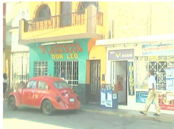
Imagen 3: Panorama de establecimientos comerciales que carecen de las adecuadas condiciones físicas espaciales; como resultado de su improvisada ejecución y por ser adaptados de viviendas y casonas de la ciudad.
